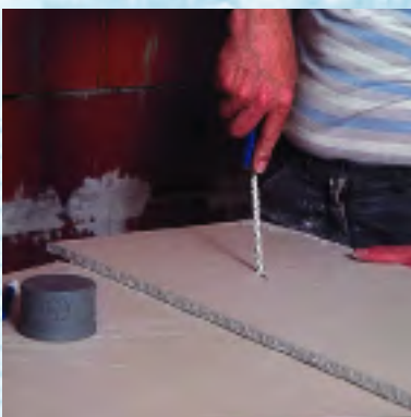
Със шило или фреза се оформят инсталационни отвори.
