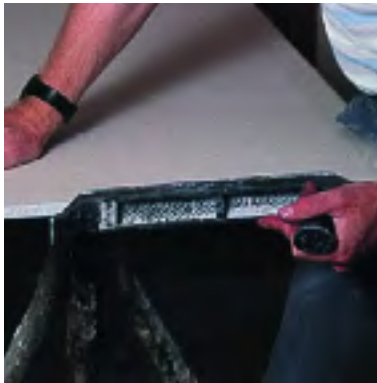
След разрязване на плоскостта кантовете се изглаждат с ренде за чело
