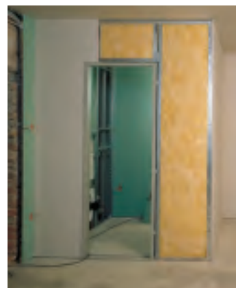
В областта на затварящите касата профили да не се разполагат фуги между плоскостите
